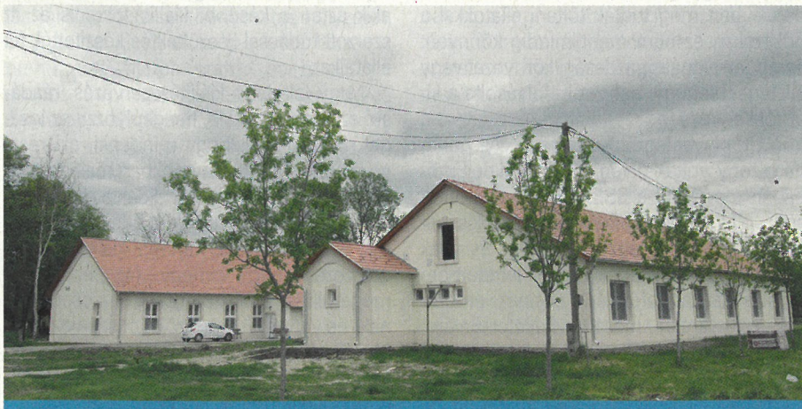
Idén felújították az állatokkal érkező gondozók szállását is
